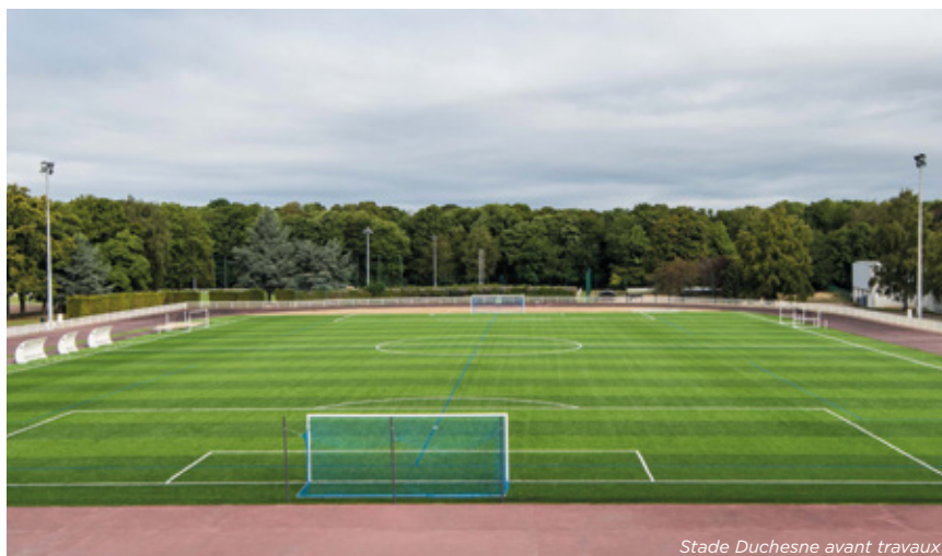
Stade Duchesne avant travaux
