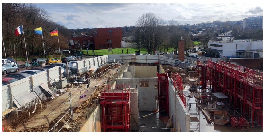
Pose de la 1 ère pierre le 3 octobre 2023
