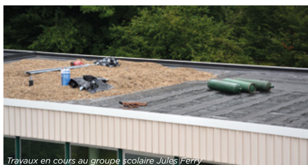
Travaux en cours au groupe scolaire Jules Ferry
