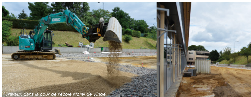
Travaux dans la cour de l'école Morel de Vindé
