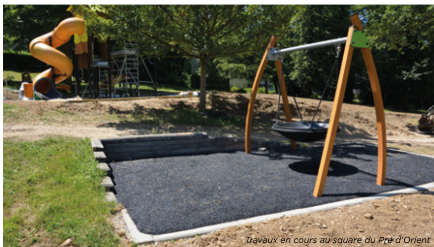
Travaux en cours au square du Pré d'Orient
