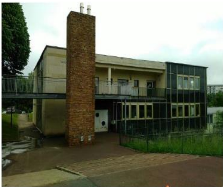
Bâtis démolis phase 1 (avant)
