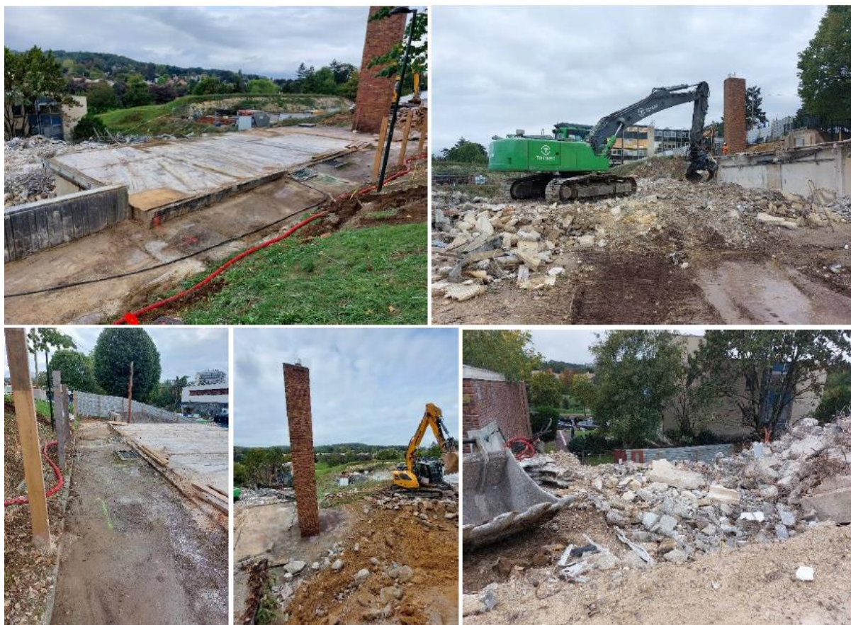
Démolition du bâtiment mixte (ex-crèche)
