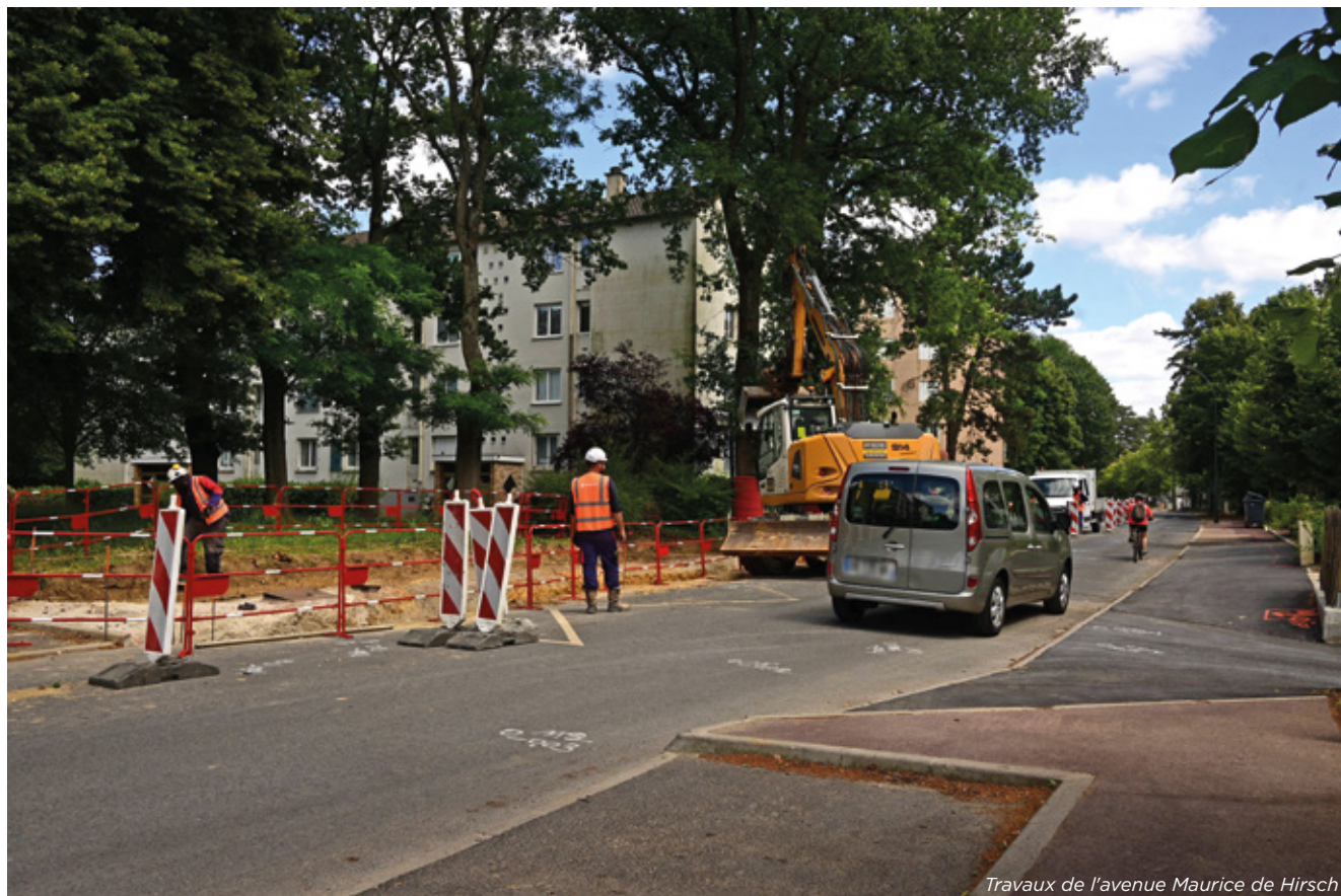
Travaux de l'avenue Maurice de Hirsch
