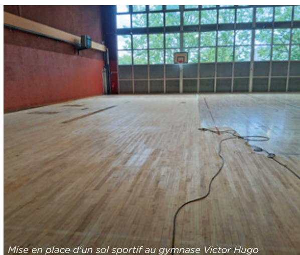
Mise en place d'un sol sportif au gymnase Victor Hugo
