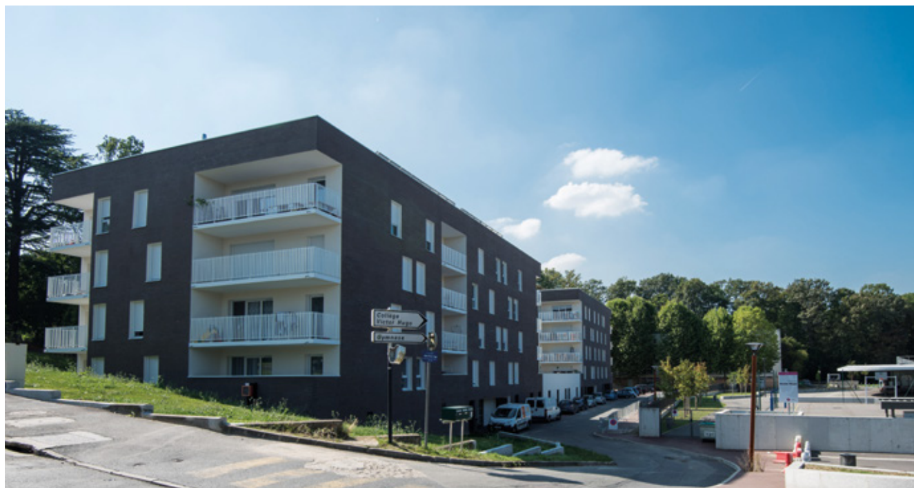
Logements du quartier Victor Hugo
