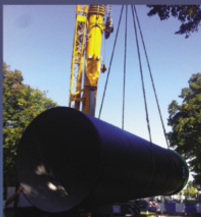
Réalisation d'un bassin de stockage des eaux Fonte diam. 2 000 X 250 m linéaires MEUDON
