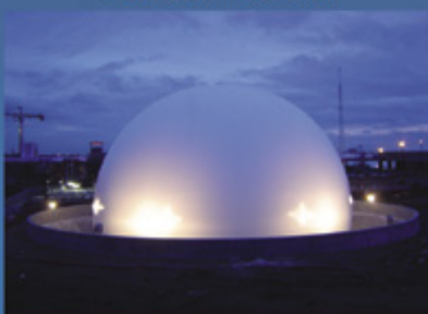
SIAAP Valenton - Gazomètre - 4 000 m 3 Travaux de génie civil en zone confinée et ATEX
