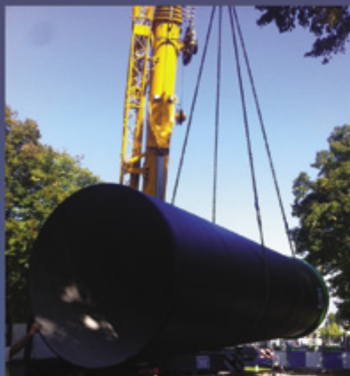
Réalisation d'un bassin de stockage des eaux Fonte diam. 2 000 X 250 m linéaires MEUDON
