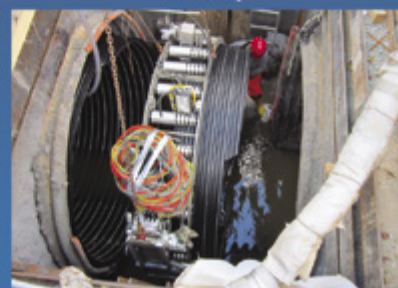
Tubage de la buse ARMCO Diam. 3 250 m X 280 m LE PECQ
