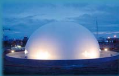
SIAAP Valenton – Gazomètre 4 000 m 3 Travaux de Génie Civil en zone confinée et ATEX
