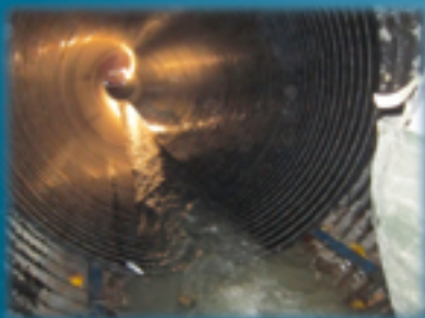
Le PECQ - Tubage de la buse ARMCO Diamètre 3 250 m sur 280 m
