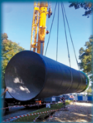
Réalisation d'un bassin de stockage des eaux Avenue du Château à MEUDON Fonte diamètre 2000 sur 250 mètres linéaires
