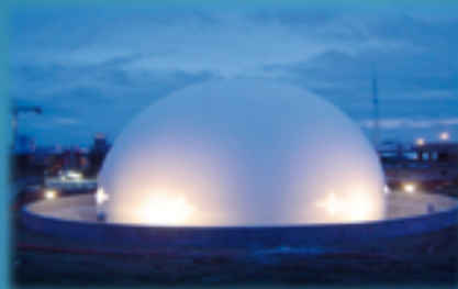
SIAAP Valentons - Gazomètre 4 000 m 3 Travaux de Génie Civil en zone confinée et ATEX
