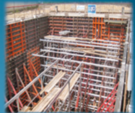
SARTROUVILLE - Rue des Eaux Bassin de stockage >2 000m 3
